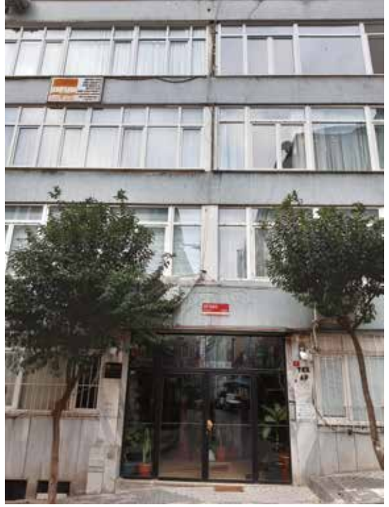
Tek Apartmanı, Üftade Sok. Elmadağ, İstanbul.
